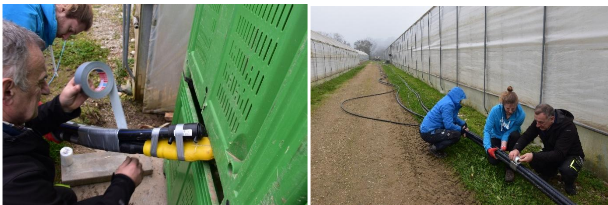
Slika 8: Povezovanje vseh 4 cevi na dnu geosonde (levo; rumeno je povezava obeh U-cevi) in po celotni dolžini (desno)
