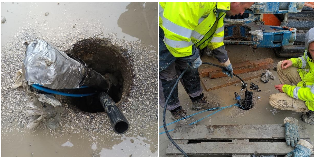
Slika 10: Ustje geosonde ob prihodu zjutraj 9. 11. – vse zaščitne vrtalne cevi so bile odstranjene (levo); dolivanje vode v U-cev za preverjanje izgub vode čez noč (desno)
