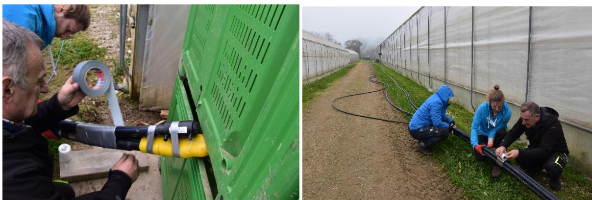
Slika 8: Povezovanje vseh 4 cevi smo začeli na dnu geosonde (levo; rumeno je povezava obe U-cevi) in ročno nadaljevali po celotni dolžini (desno)
