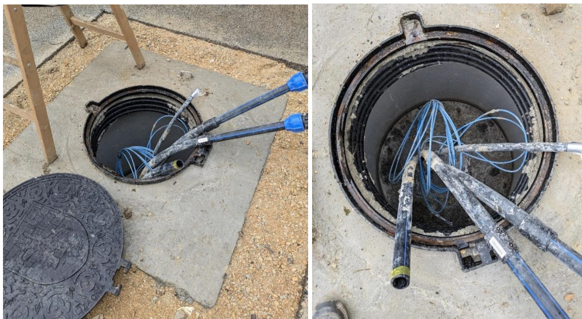
Slika 12: Izgled ob izdelavi jaška. U-cev ima prehod iz premera 45 na premer 40 mm na površini, leva cev z modro črto je 30 mm opazovalna cev in mala 25 mm je za cementacijo.
