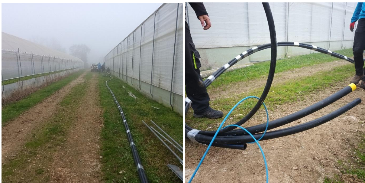
Slika 9: Že povezane cevi v enotno verigo: 45 mm črna U-cev, 32 mm črna z modrimi črtami opazovalna cev, 25 mm cev za cementacijo in tanjši svetlo moder optični kabel, ki je na dnu zviti
