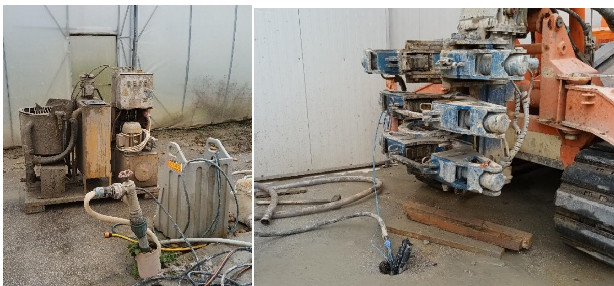
Slika 11: Naprava za pripravo cementne mešanice (levo) in izgled geosonde med cementiranjem - priključena je cev za cementacijo (levo)
