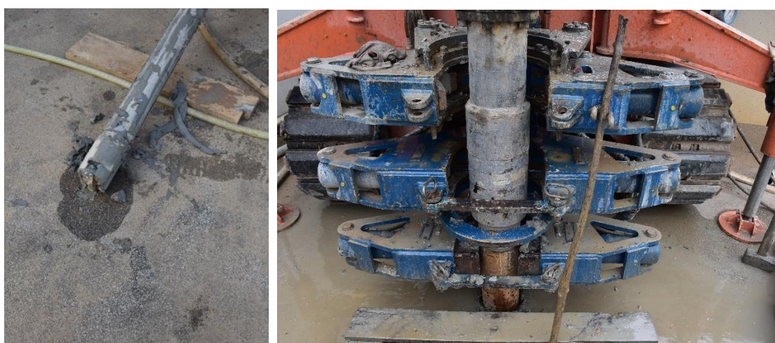
Slika 4: Vrtalna glava (levo) in začasna vrtalna kolona med vrtanjem (desno)
