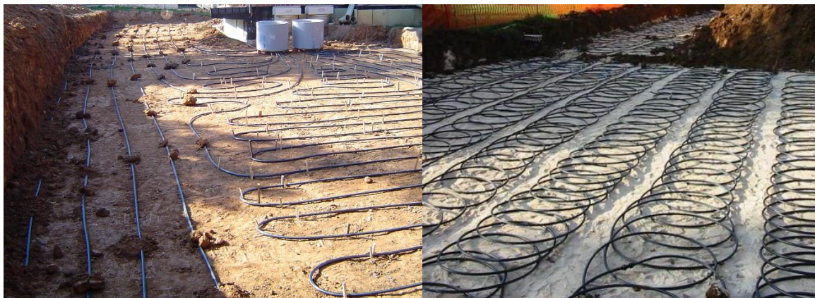
Slika 14: Prikaz linijskega in zankastega polaganja vodoravnih prenosnikov
