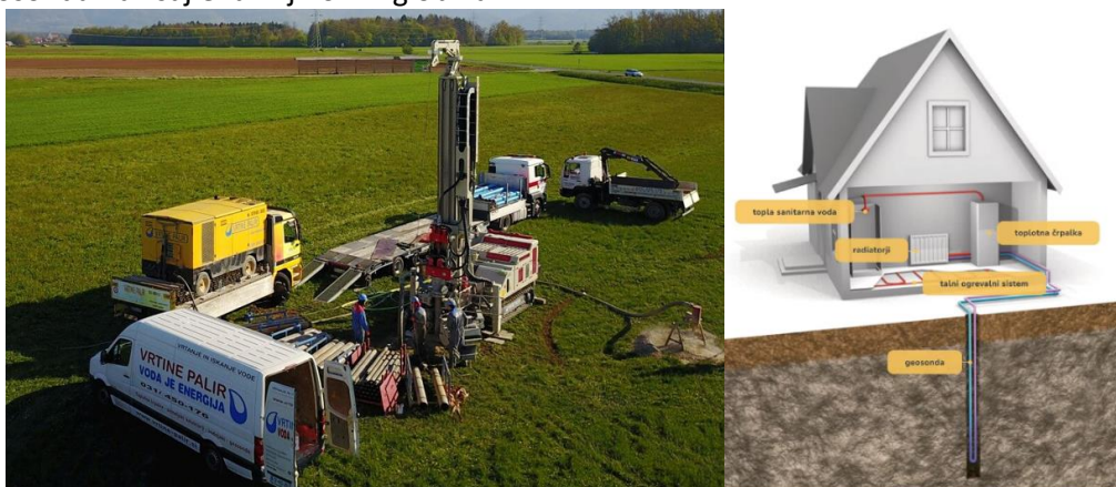
Slika 16: Prikaz vrtanja in shematski prikaz postavitve geosonde Vir: Palir, Atlas
